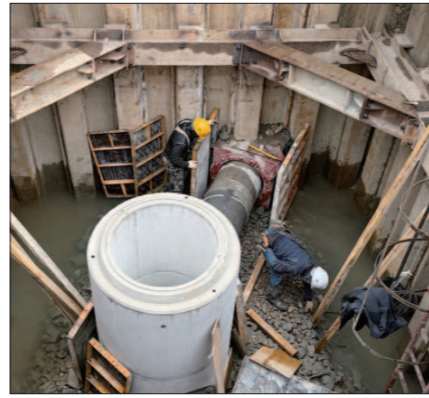
나주시가 시민을 위한 쾌적한 수질 환경 확보와 침수 피해 예방을 위한 올해 428억 원 규모 하수도 정비사업에 착수한다. 사진은 하수도 정비 및 나주전 일원 공공하수처리장 차집관로 정비 장면.
