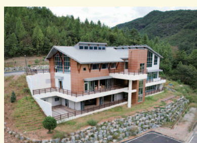
화순 - 지류센터 목구조 설계지원 및 시공
