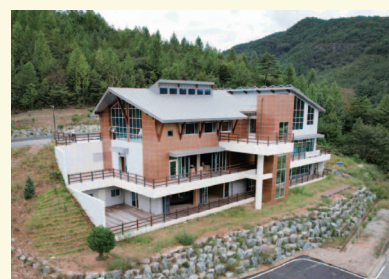
화순 - 지류센터 목구조 설계지원 및 시공
