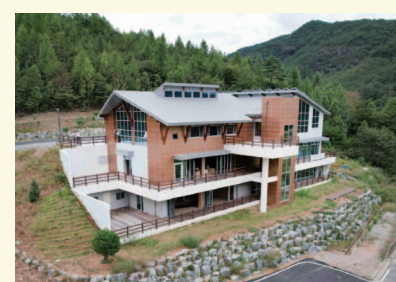
화순 - 지류센터 목구조 설계지원 및 시공
