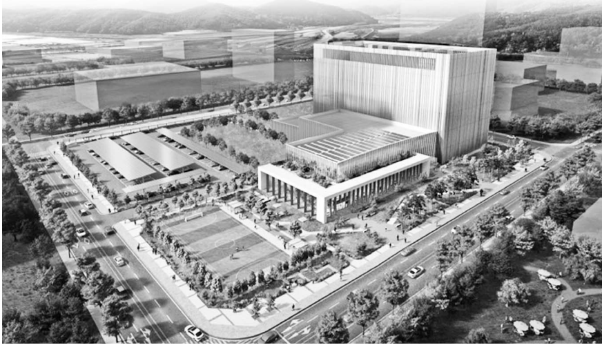
장성 남면 첨단3지구 부지에 조성되는 장성 파인데이터센터 조감도.
