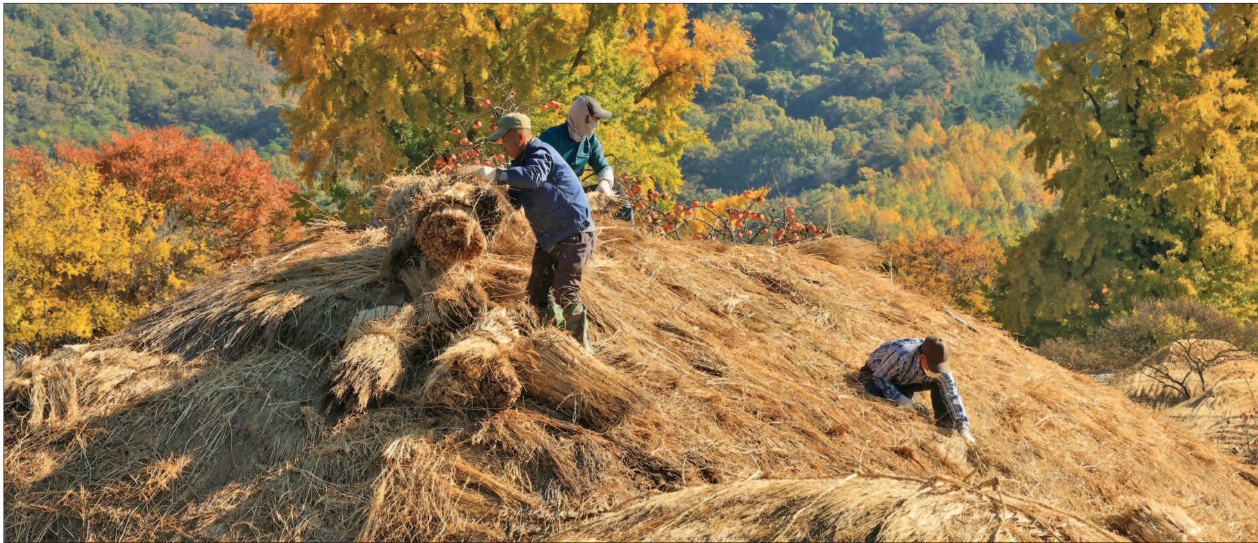
낙안읍성 초가지붕 이엉 잇기 17일 전남 순천시 낙안읍성 민속마을 주민들이 겨울을 맞아 초가지붕 지붕을 새 볏짚으로 바꾸고 있다. 낙안읍성마을 전통민속초가지붕 이엉 잇기 작업은 300여 동의 초가지붕을 대상으로 12월까지 진행하며, 전통기술 보유 주민과 장인들이 베풀 수확 시기에 맞춰 매년 시행하고 있다.
