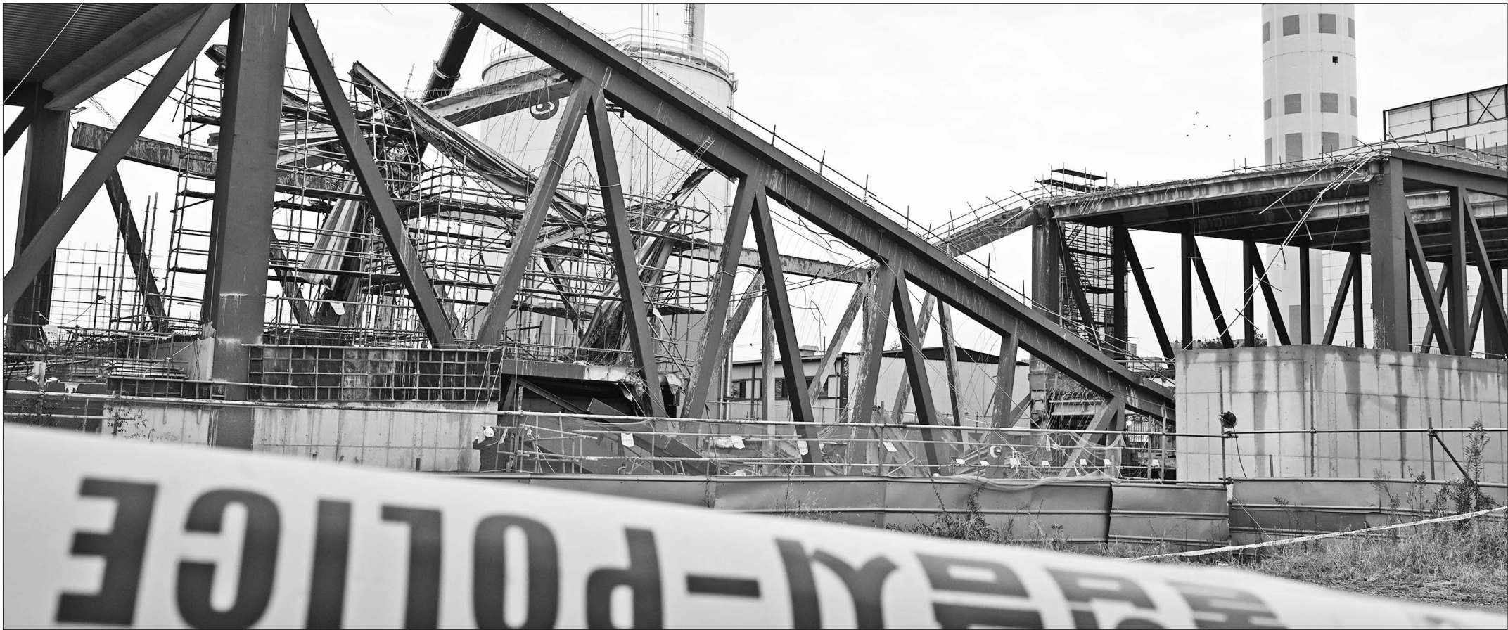
14일 오후 광주 서구 치평동 광주대표도서관 붕괴 사고 현장에서 공사 관계자가 현장을 둘러보고 있다. 붕괴사고는 콘크리트 타설 중이던 2층 지붕 옥상층에서 시작됐고, 사고원인은 철골 구조물의 접합 불량 등을 지목되고 있다. 최기남 기자 bluesky@gwangnam.co.kr
