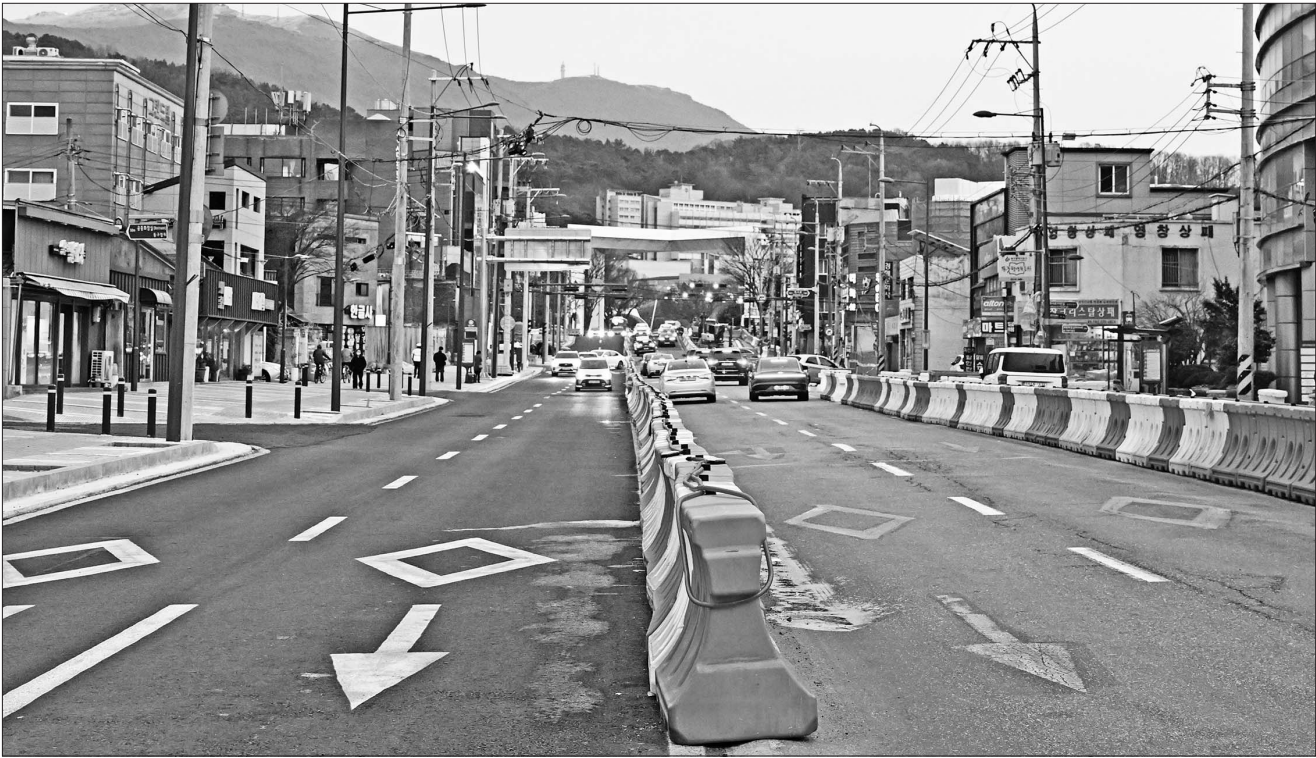
오는 3월 개통을 앞둔 국립아시아문화전당과 조선대학교를 연결하는 ‘광주 동구청~조선대 학교 사거리’ 도로 확장 마무리 공사가 한창이다. 왕복 4차로 구간(375m)의 도로 폭을 가변형 왕복 5차로로 확장한다.
