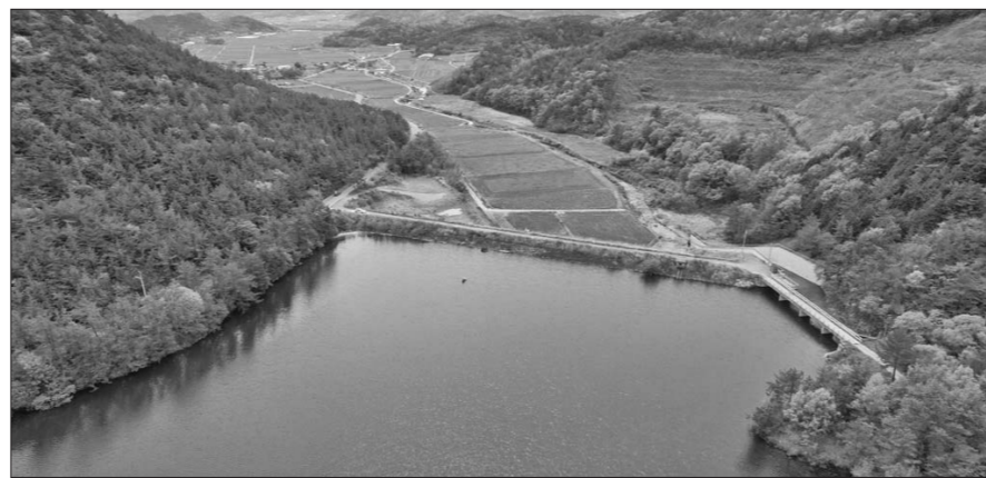
화산지구 다목적 농촌용수 개발사업 대상인 군동면 화산저수지. 사진제공=강진군청
