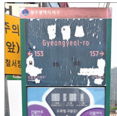
광주 서구 양동시장 인근에 도로명주소와 주요 시설·관광지 등이 담긴 도로명주소 표지판은 형태를 알아볼 수 없을 정도로 훼손됐다.
