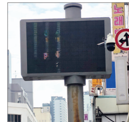
광주 동구 '전자의 거리'에 설치된 LED 전광판이 고장 나 화면이 정상적으로 작동하지 않고 있다.
