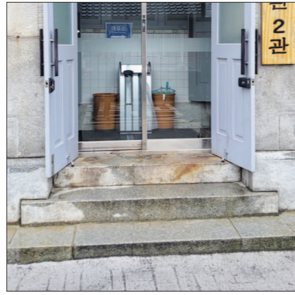
목포지역 장애인·시민단체들이 역사·문화시설 등 공공시설 장애인 이동권 실태의 심각성을 제기하며 전면 재조사와 즉각적인 개선을 촉구했다. 사진은 목포 근대역사관 2관(구 중앙척식주식회사) 전경과 목포오거리문화센터(구 동본원사) 전경.
