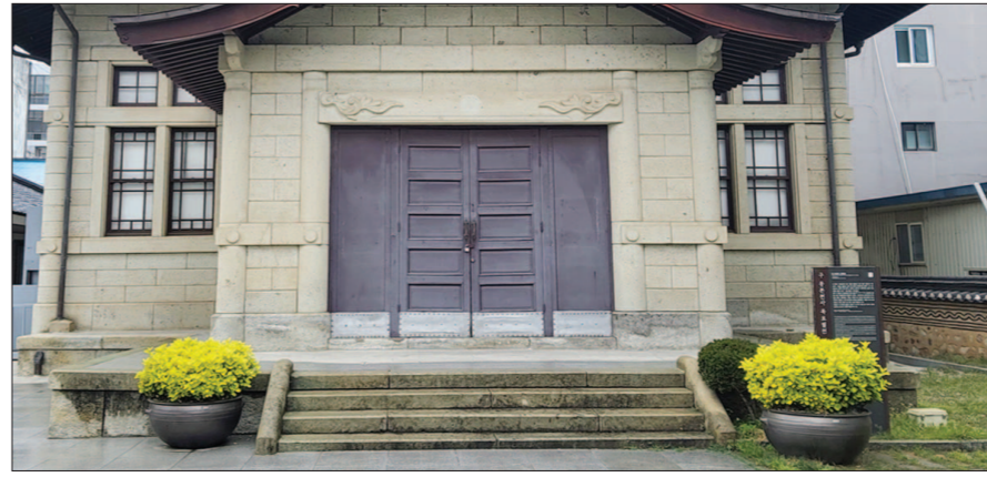
목포지역 장애인·시민단체들이 역사·문화시설 등 공공시설 장애인 이동권 실태의 심각성을 제기하며 전면 재조사와 즉각적인 개선을 촉구했다. 사진은 목포 근대역사관 2관(구 중앙척식주식회사) 전경과 목포오거리문화센터(구 동본원사) 전경.
