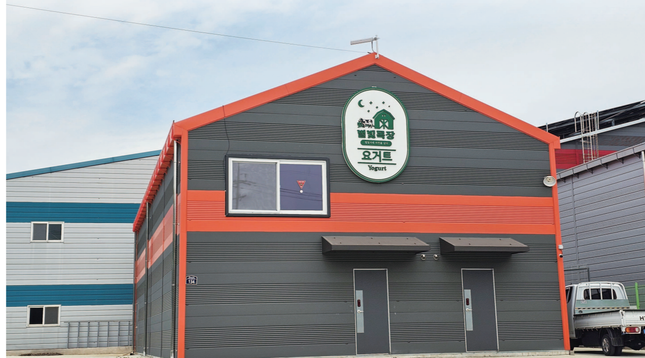
전남 화순 동면에 위치한 별빛목장 전경.
