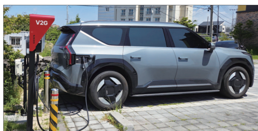
현대차그룹의 제주도 EV2G 실증 시범서비스 참여 고객은 제주시 논제리 소재 자택에 설치된 양방향 충전기를 가이 EV9이 이용하는 모습.
