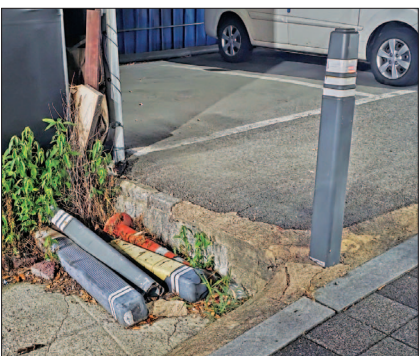
전남광주통합특별시 서구 운전사거리 인근 상가 앞에 버려진 채 방치된 볼라드.
