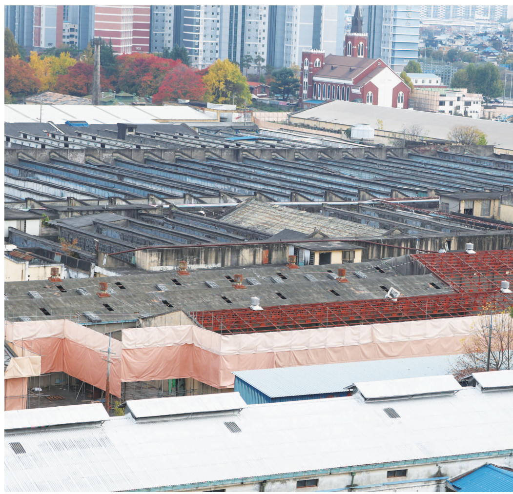
철거되기 전 광주 임동 방직공장 전경.
